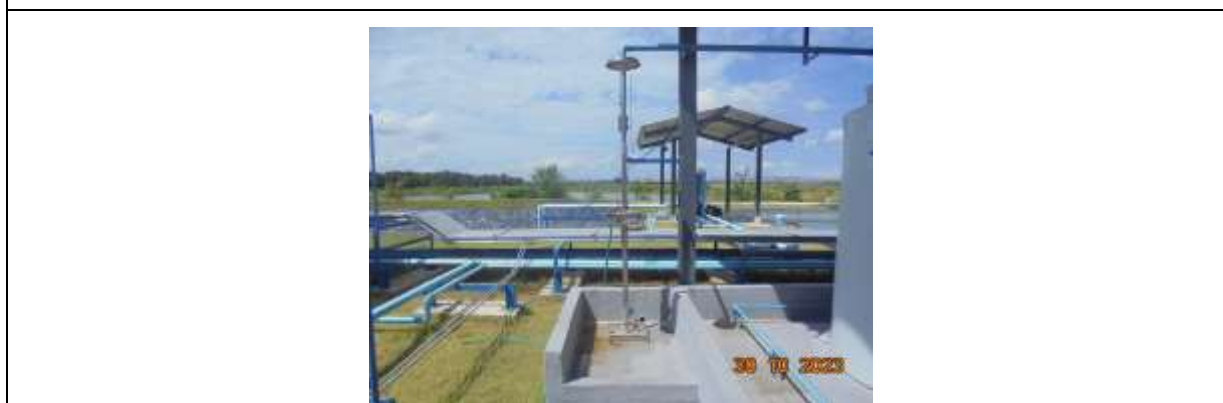
รูปที่ 27 ฝักบัวฉุกเฉินและอ่างล้างตา
